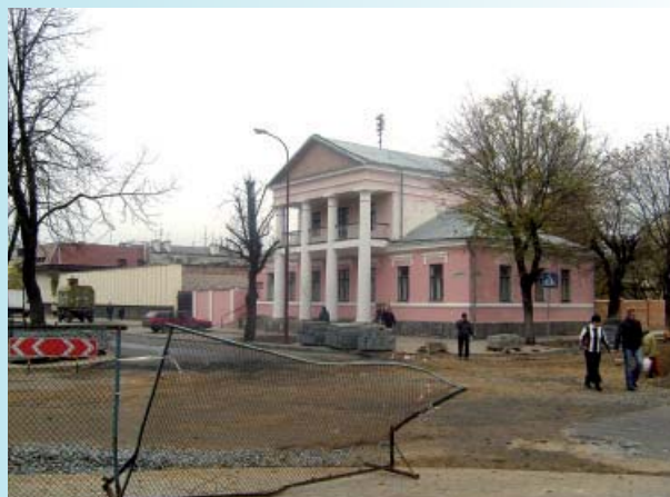
Wszędzie trwają prace remontowe
